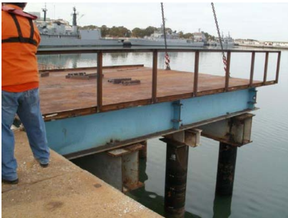
Plataforma durante la construcción
